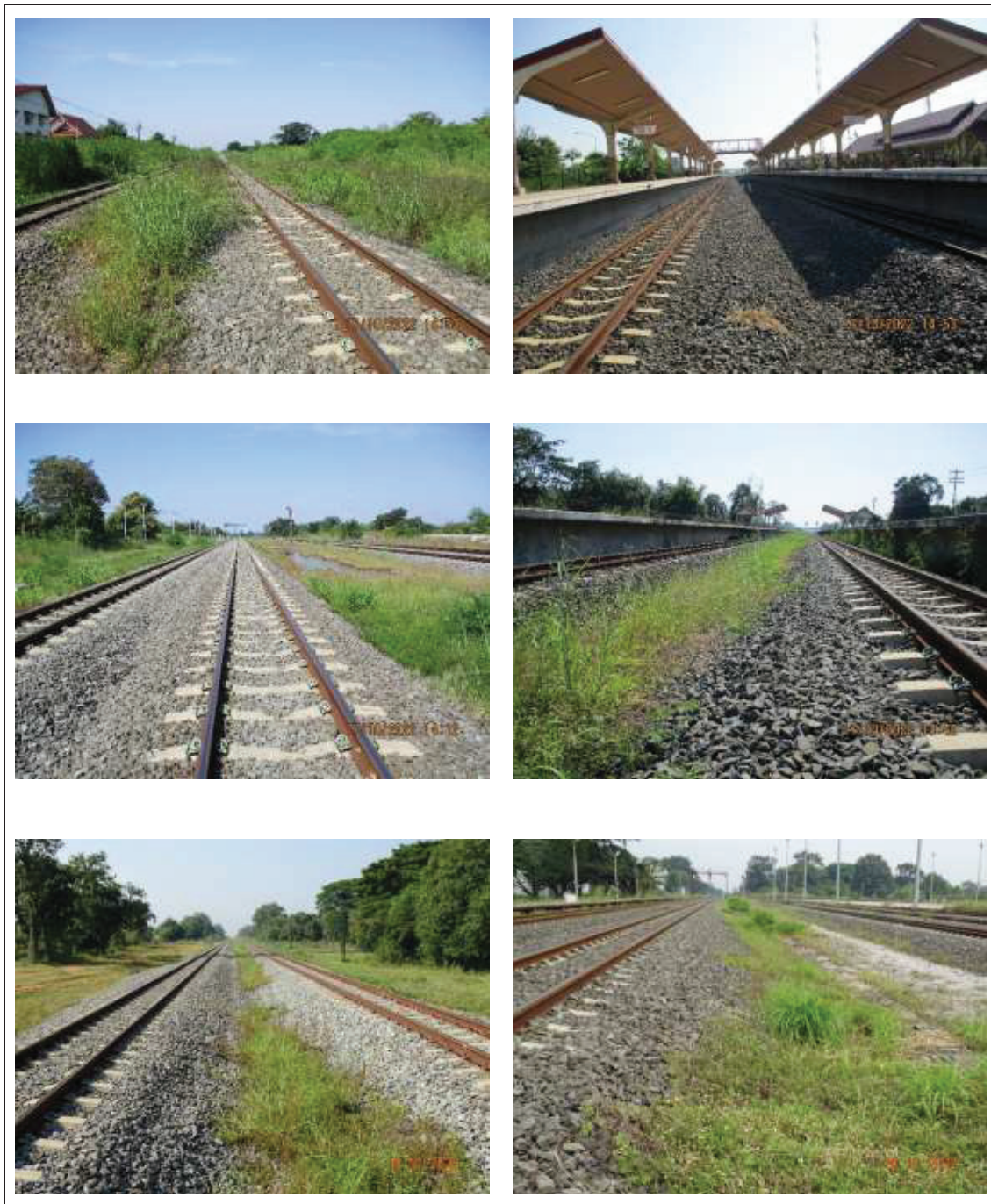
รูปที่ 2.2-4 พืชคลุมดินและการโยหินกรวดเพื่อป้องกันการชะล้างพังทลายตลอดแนวทางรถไฟ
