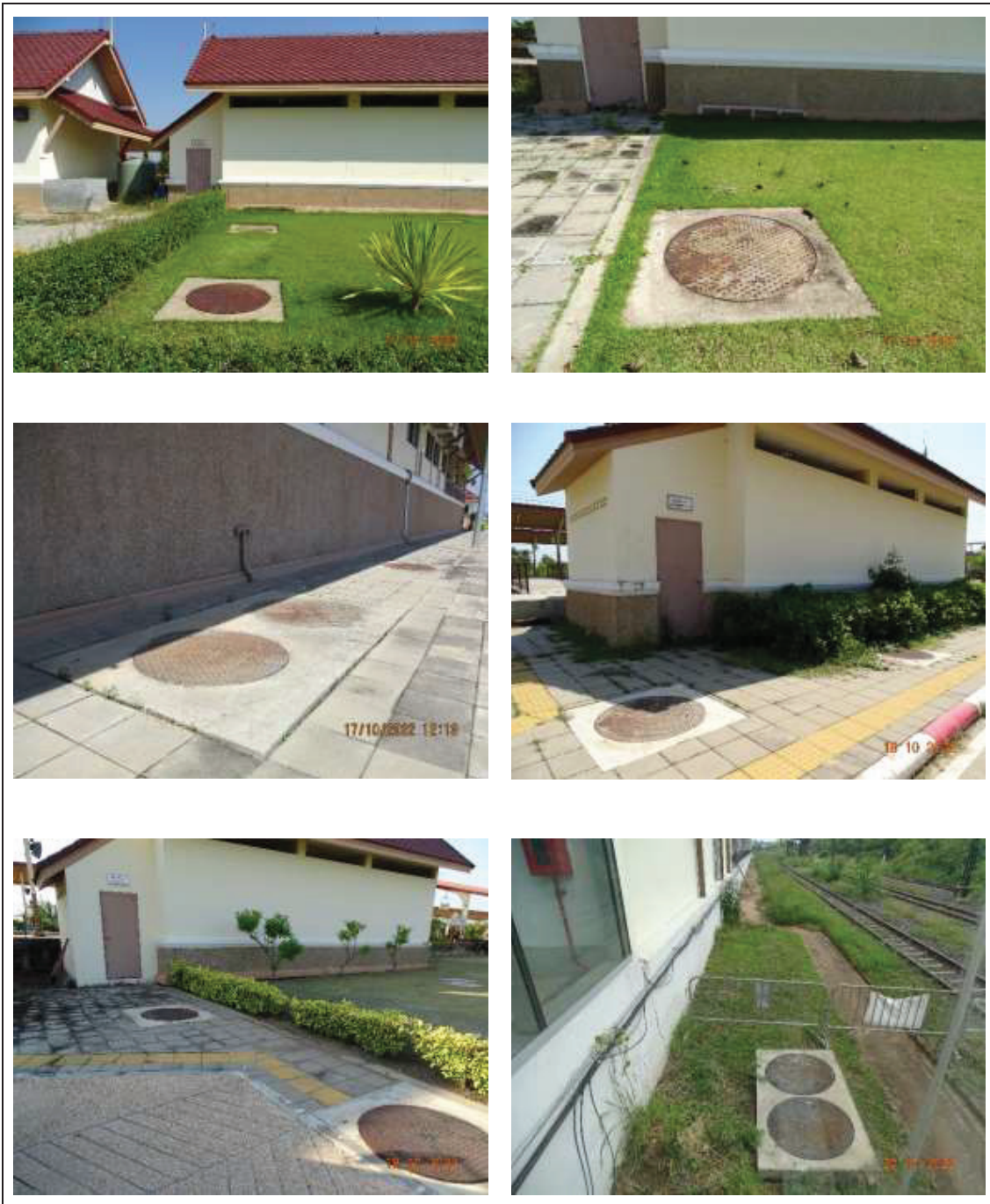
รูปที่ 2.2-2 ถังบำบัดน้ำเสียสำเร็จรูปที่ติดตั้งด้านหลังห้องน้ำของสถานีรถไฟ
